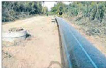
Construcció del nou col·lector entre Sant Vicens i Castellbò
