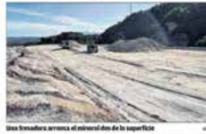
Una fàbrica arreu de la muntada de la superfície
