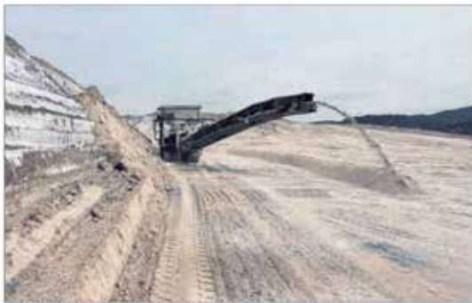
La màquina fronedora treballant damunt del runam
