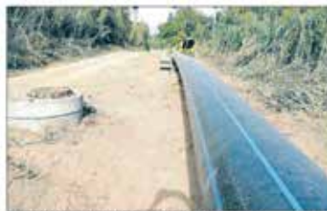
Construcció del nou col·lector entre Sant Vicenç i Castellbò
