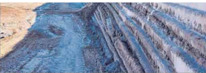
Activitat d'exploració i restauració del dipòsit salí de la netja de salmures
