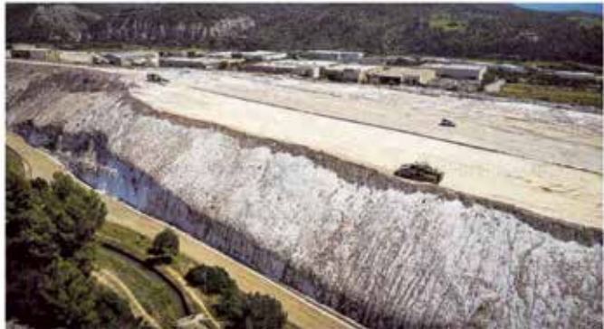
Part superior del ramal de la Botjosa, amb maquinària treballant, i que mostra el material que ja se n'ha extret
